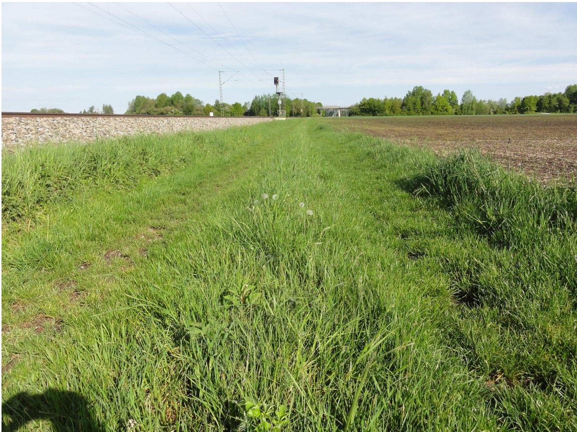
Abb. 3: Bahnschotter und daran anschließender Grünweg im Bereich von FINr. 365 (Aufnahme 13.5.2019).
