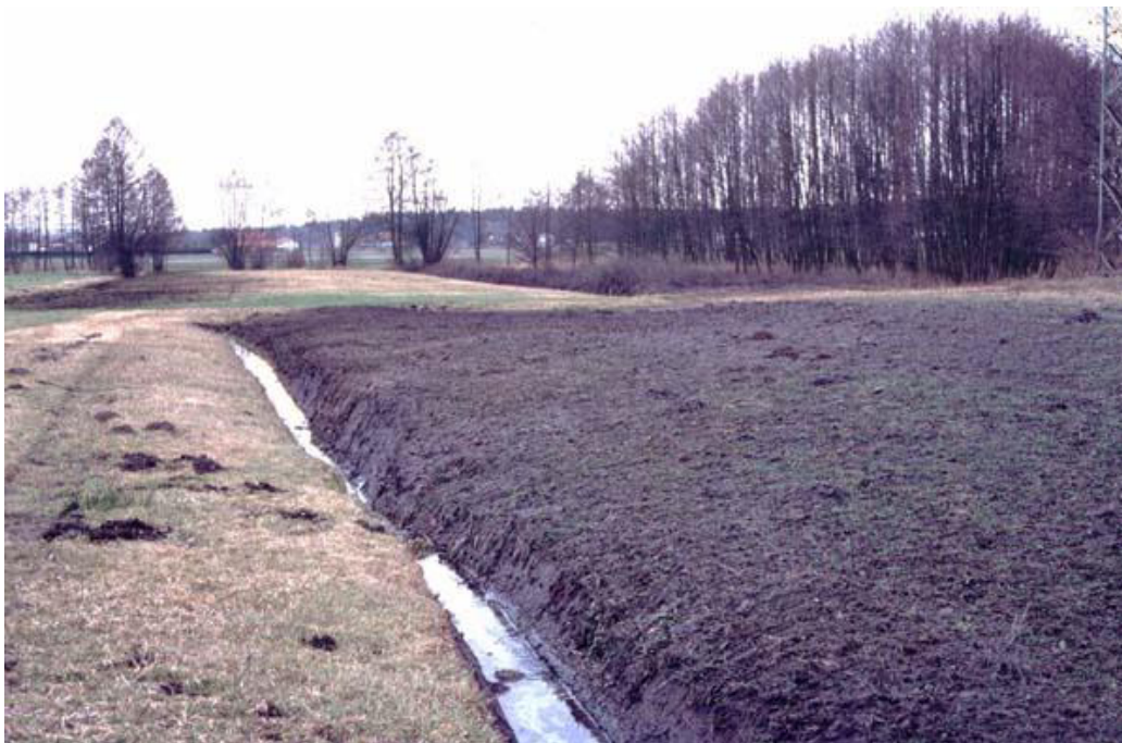
Grabenräumung mit der Grabenfräse:
